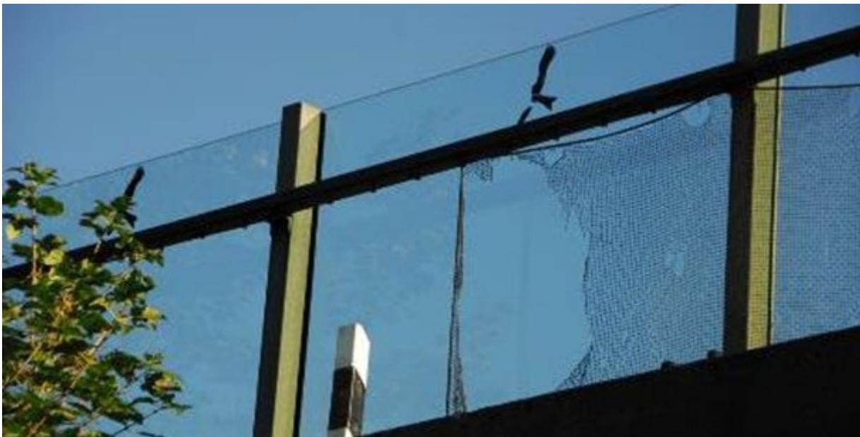
*Abb. 7: Gläserne Lärmschutzwand auf einer Brücke. Ein paar Silhouetten und ein beschädigtes Netz verhindern Vogelkollisionen nicht (B.-U. Rudolph)*
