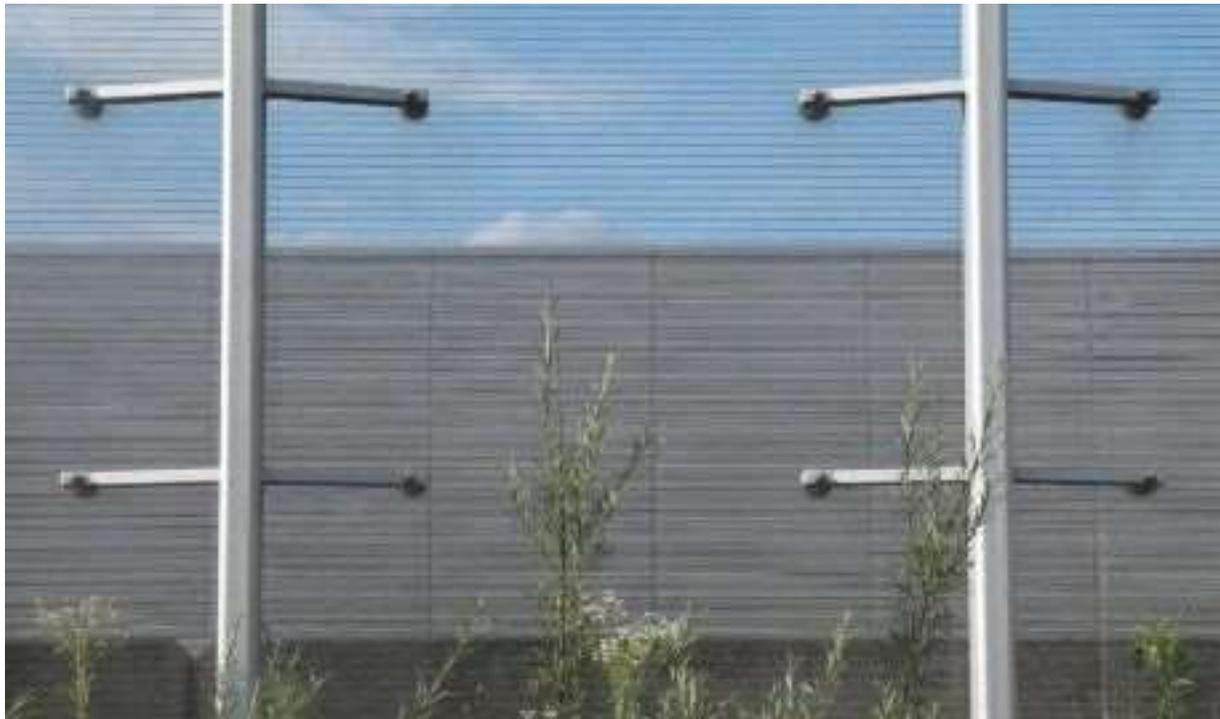
Abb. 5: Als wirksam gestestete Streifenmarkierung an einer Lärmschutzwand (B.-U. Rudolph)
