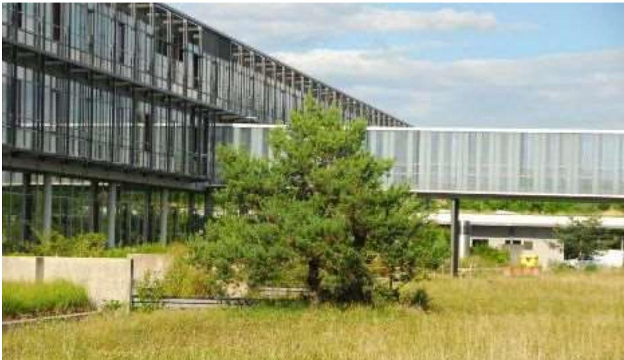
Abb. 21: Übergang zwischen zwei Flügeln eines Verwaltungsgebäudes mit vogelsicheren, mattierte Scheiben (B.-U. Rudolph)
