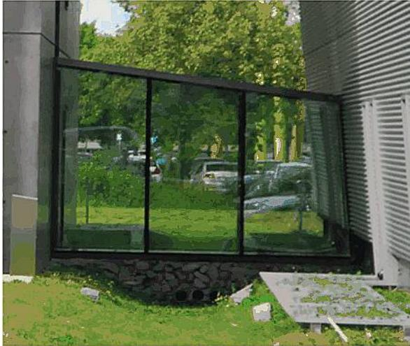
Abb. 11: Transparenter, beidseitig verglaster ebenerdiger Übergang zwischen zwei Gebäudeflügeln; Vogelverluste sind hier nachgewiesen (B.-U. Rudolph).
