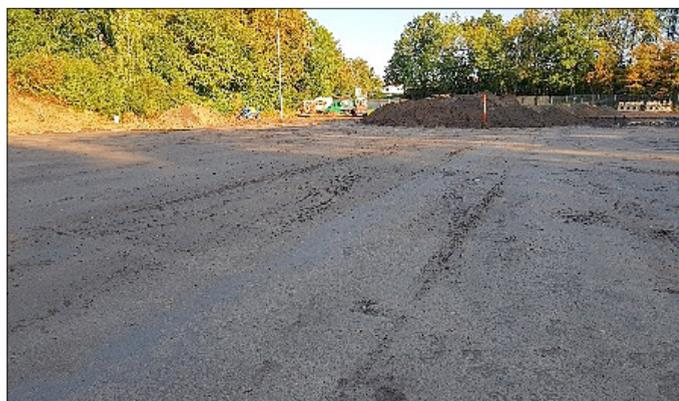
Die beigefügten Fotos sind kurz nach einer längeren Regenperiode entstanden und geben die Bestätigung ab, dass das eingebrachte Dränagesystem die erste Bewährungsperiode bestanden hat. Allerdings war der Boden bei Redaktionsschluss stark aufgeweicht, so dass die notwendigen Folgearbeiten, wie das Einbringen der Maulwurfssperre und das Aufbringen der restlichen 8 - 10 cm
